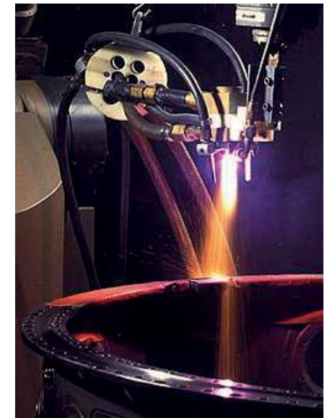
Pretrattamento di una superficie da rivestire
